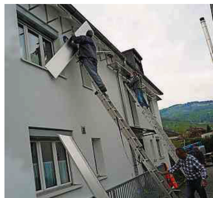
Nach langer Planung wurden Nisthilfen und Kotbleche für die Mehlschwalben-Kolonie im Sonnmattquartier installiert.
